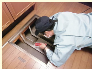
土台・床組・基礎調査
